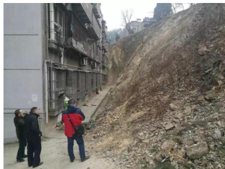
适用技术方法：电测深法、高密度电阻率法、地质雷达法、瑞雷波法。
