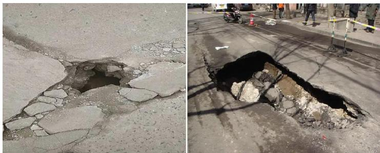
适用技术方法：瞬态面波法、地质雷达法、高精度地震映像法、光学法、管线探测、地震反射波法、瑞雷波法、高密度电阻率法。
