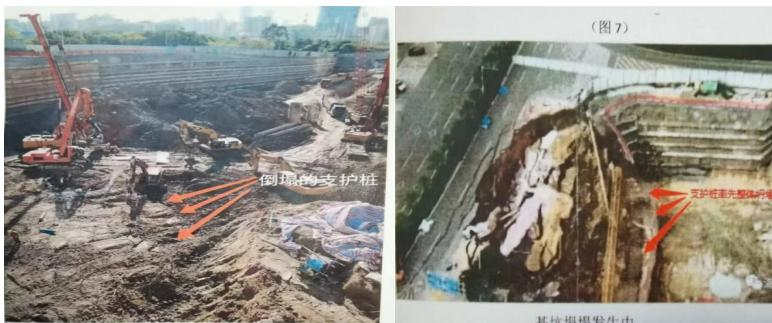
给水管道长时间漏水、致周边岩土体脱空，给水管道变形、爆裂致使旁侧深基坑锚索、锚杆锁力失效，支护桩发生倾斜、倒塌，最终导致市政道路路面大范围塌陷。市区基坑工程应限制使用锚索（杆），减少对周边建筑物干扰。
