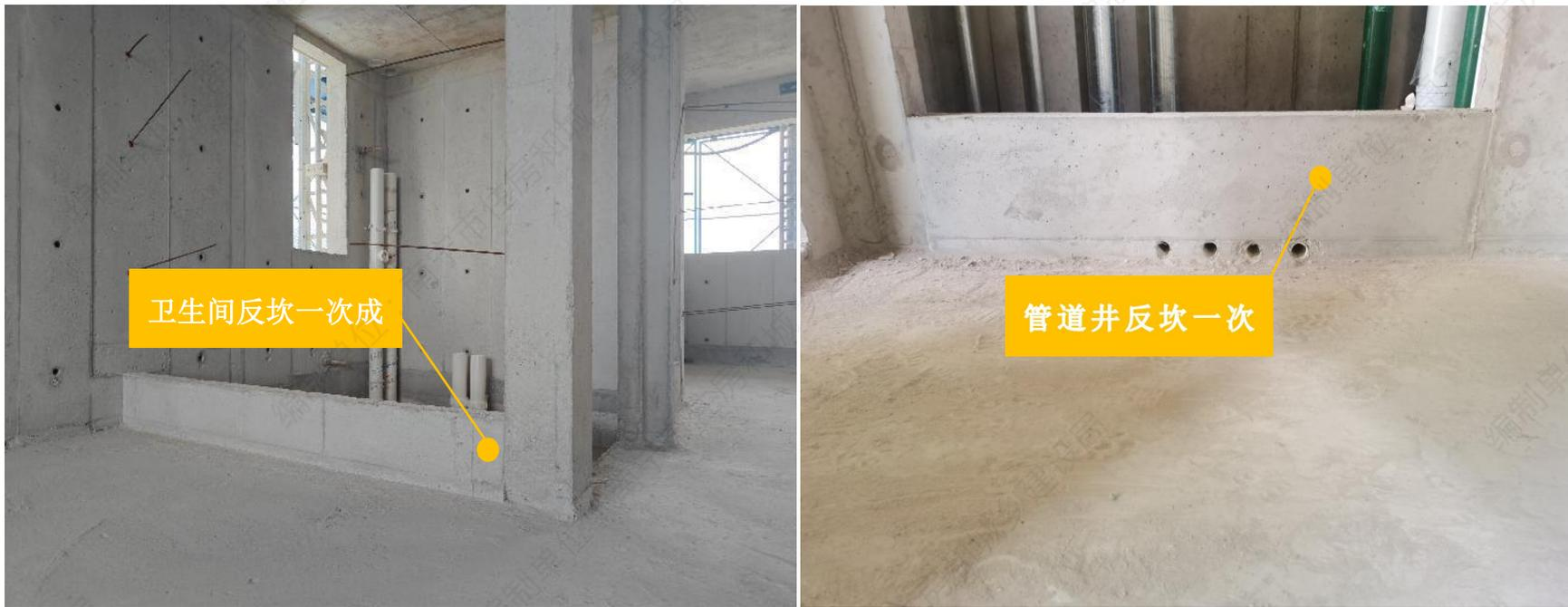
管道井反坎、卫生间反坎深化一次成型示意图
