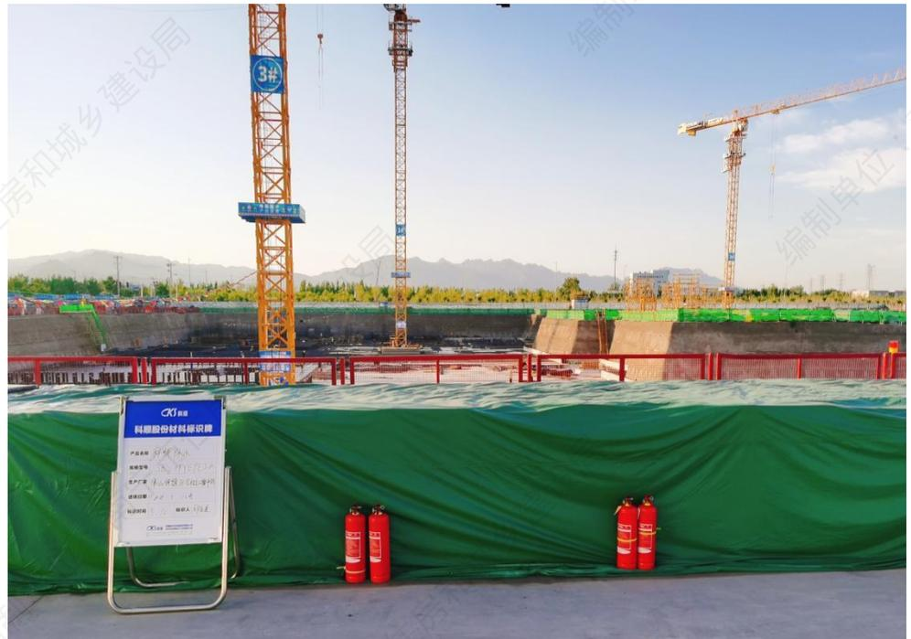
建筑材料分类堆放设置材料标识牌和遮阳避雨措施
