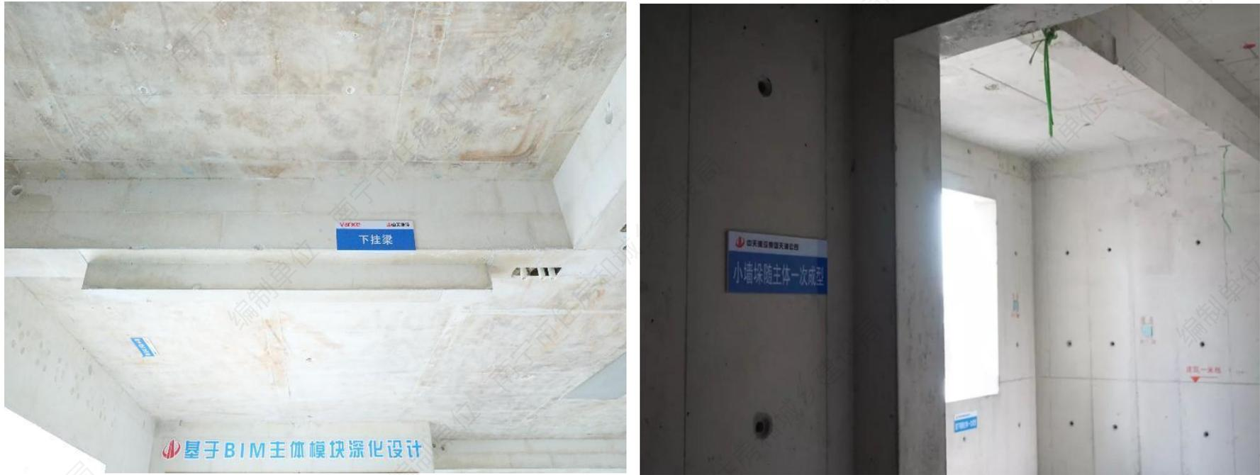
反坎、门垛深化一次成型示意图
