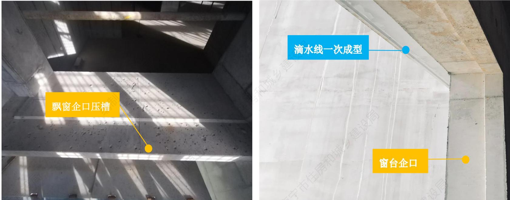
下挂梁、滴水线、窗台企口深化一次成型示意图
