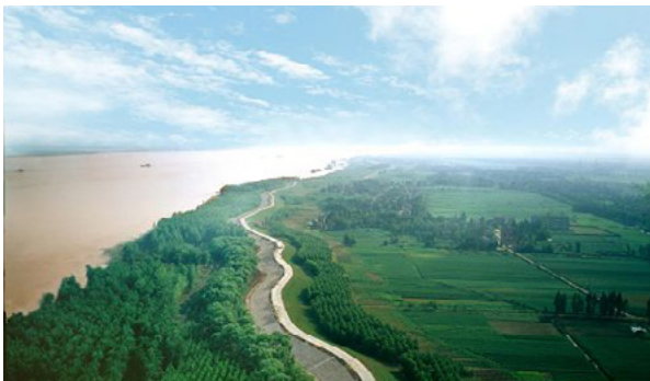
长江重要堤防加固工程
