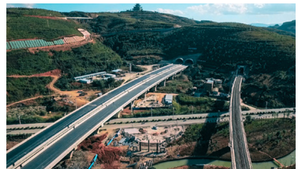
云南大理海东新城中心片区双月路、览川路隧道
