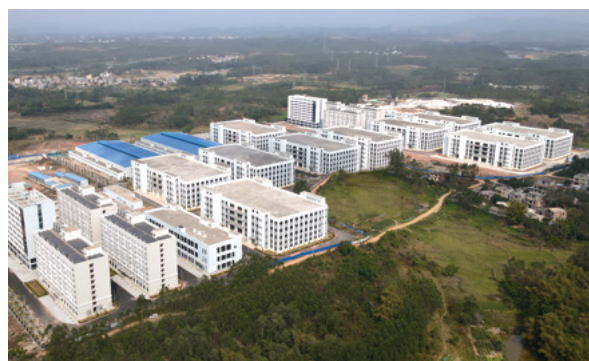
广西玉林龙潭产业园高端铜制品产业基地工程
