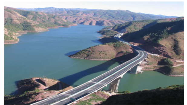
云南昭待高速公路深水沟大桥
