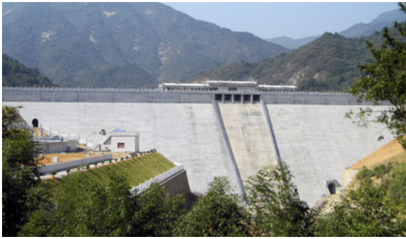
湖南衡阳南岳兴隆水库大坝
